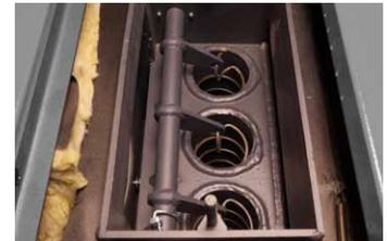
**Fig. 6** : Tubes échangeur de chaleur avec turbulateurs
